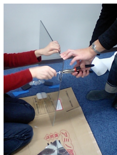
(d) シートをアクリル板の大きさに揃える
